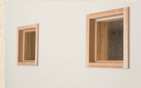
廊下には明かり採りのために小さな窓をつけて
