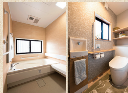
トイレはご主人の動作寸法を確認してから、手すりの高さを決定した。浴室にも至るところに手すりを設置
