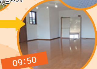
09:50 古賀市の駐車場とダンススタジオ改修工事の現場に。
