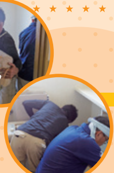
15:00 現場には熊本大工と設備スタッフのクラフトマンが。
