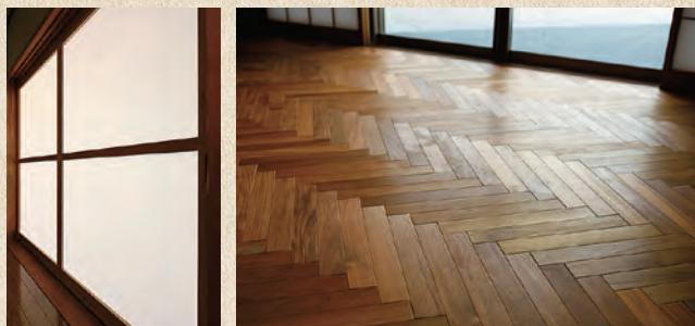
重厚な床はチーク材のヘリンボーン張り。職人の正確な技術が見て取れる美しい仕上がりに。廊下に面した扉は幅の広い造作引き戸へ。開け放つと廊下からも庭が良く見える
