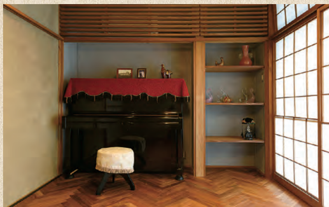
ニュアンスのある元の壁を活かし、壁の一部を炭を練りこんだ漆喰で塗装した
