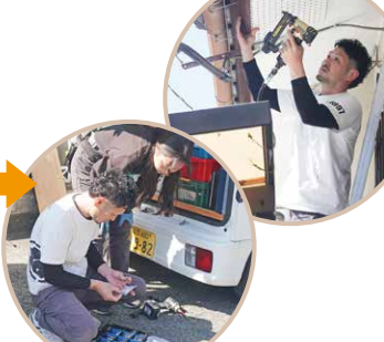
部下の石井さんに教えながら 現場を進めています。
