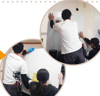
新しいボードの貼付け作業。
