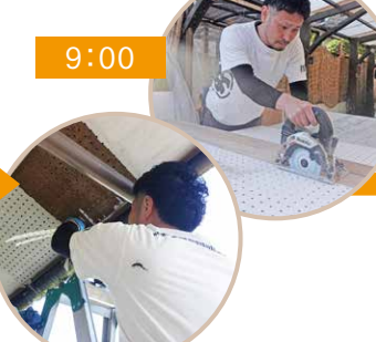
福津市B様邸での軒下のボードの 貼替えと基礎クラックの補修工事。
