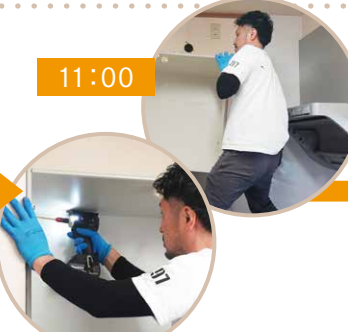
福津市I様邸で食器棚の解体と ボードの貼付け。
